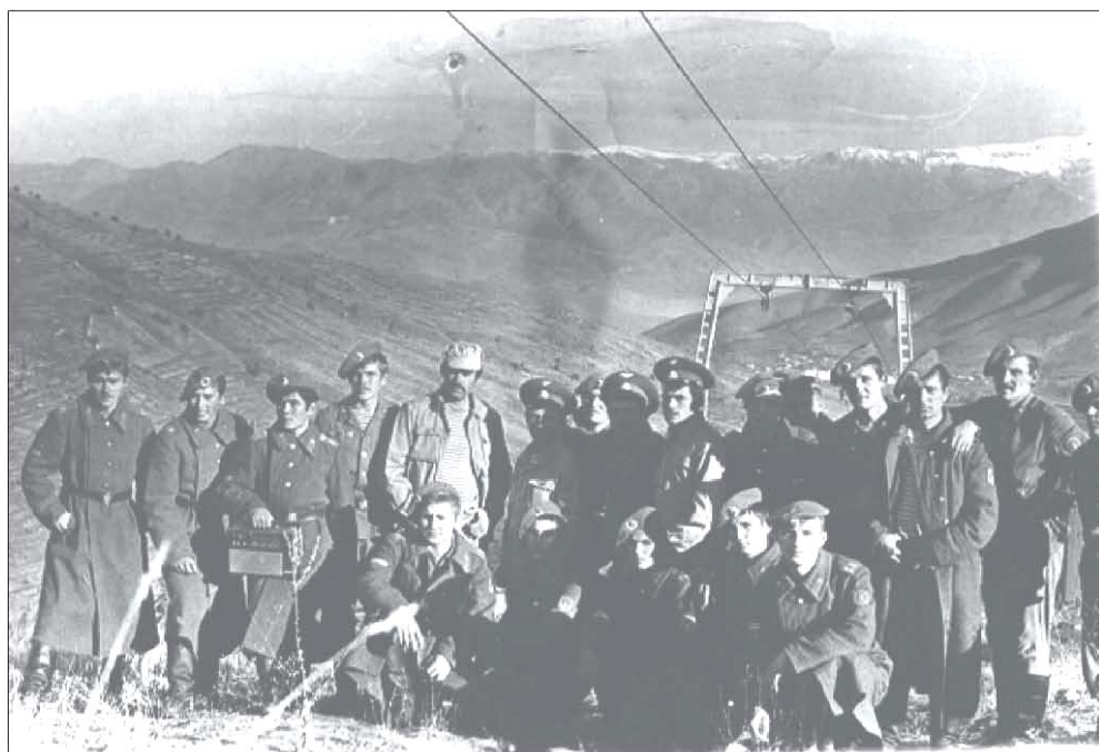
Фото под канатной дорогой
